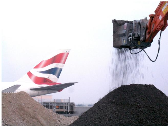
*Bei der Errichtung einer Einphasenschlitzwand in der Kombination mit RSS Flüssigboden am Londoner Flughafen Heathrow kam der SkanCraft Claymaster bei der Aufarbeitung der stark bindigen Böden des London Clay erfolgreich zum Einsatz.*
